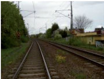
Innan uppförandet av bullerskärm
